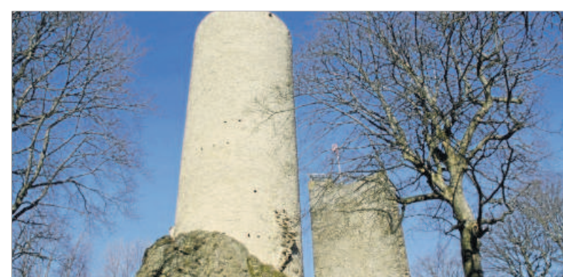
Der runde Burgturm (links) der bereits 2015 renoviert wurde, ist deutlich heller als der eckige Wohnturm.
