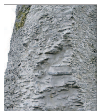
An der Schildmauer drohten Steine auszuberechnen.
